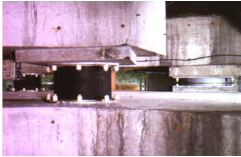
Figura 11 "Izolator din cauciuc natural montat în sit"
