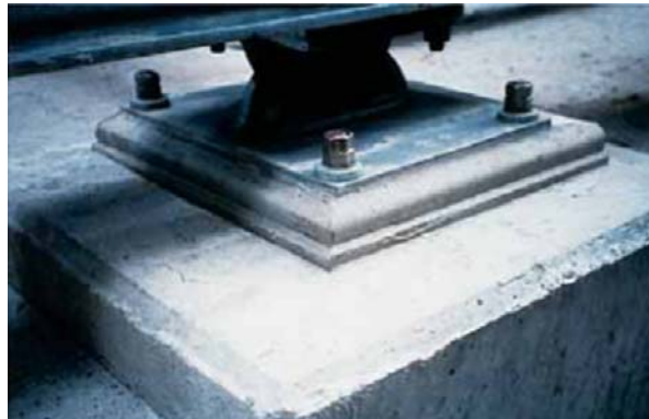
Figura 27 Mortar de subturnare folosit pentru sisteme de reazeme
