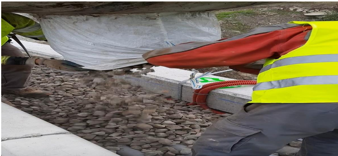
Fig. 4 Așternerea sticlei celulare din saci Big Bag
