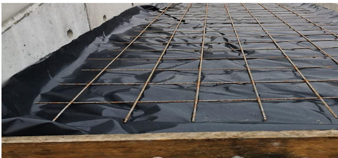
Fig. 6 Așternerea foliei de polietilenă și armarea cu plasă sudată
