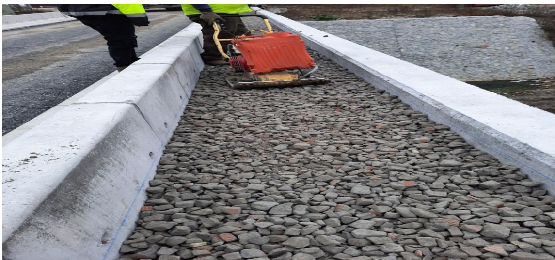
Fig. 5 Compactarea sticlei celulare cu placa vibratoare la trotuare
