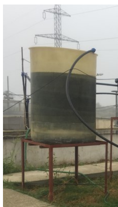
Figura 3 – Decantorul primar
