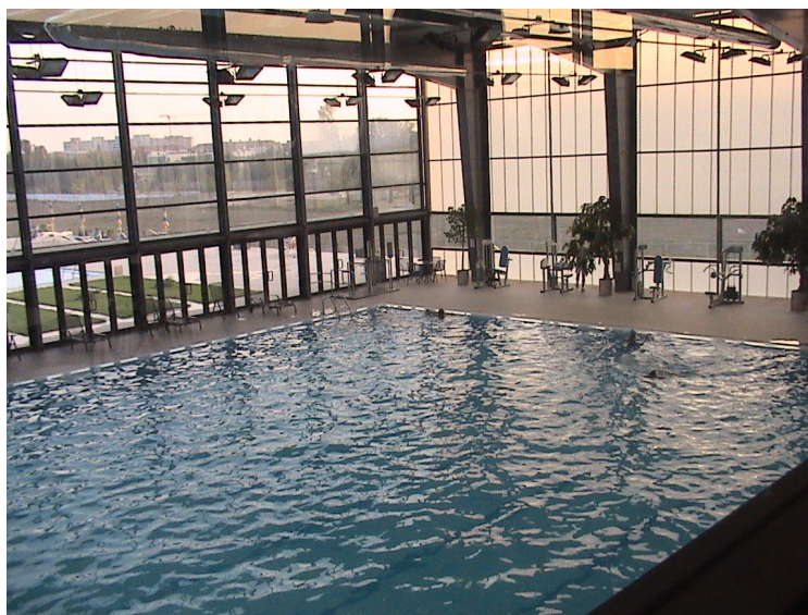
Fig. 14 - Calitatea apei și a construcțiilor de la bazinul de înot T 4
