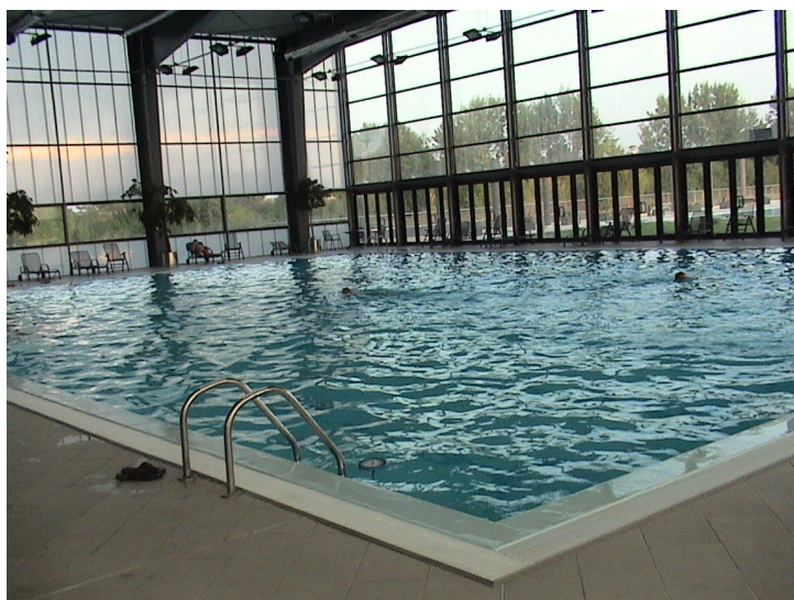
Fig. 13 - Calitatea apei și a construcțiilor de la bazinul de înot T 4
