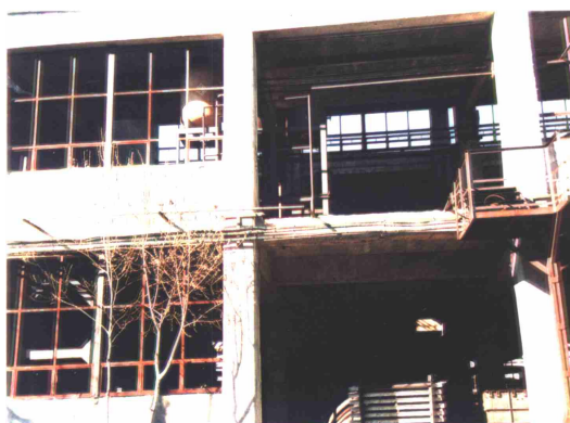
Fig. 2. Hala “INTERMEDIARI B 1 ” – vedere exterioară
