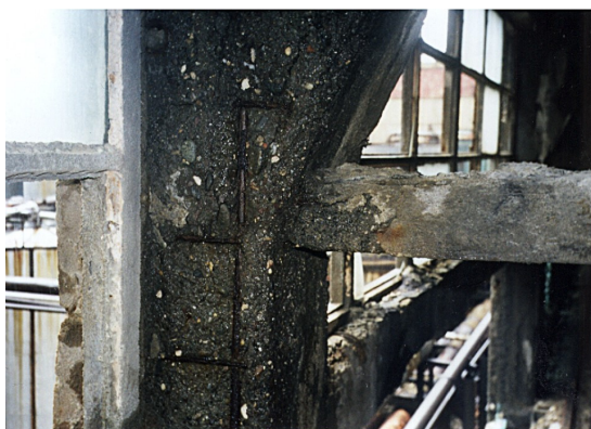
Fig. 6 – Depozit de sulf – stâlp și consolă șir A ax 2
