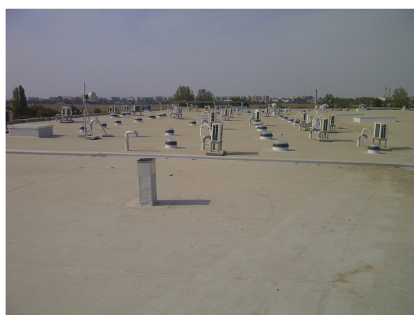
Fig. 4. Iluminarea naturală a birourilor și amplasarea tuburilor de lumină pe terasă
