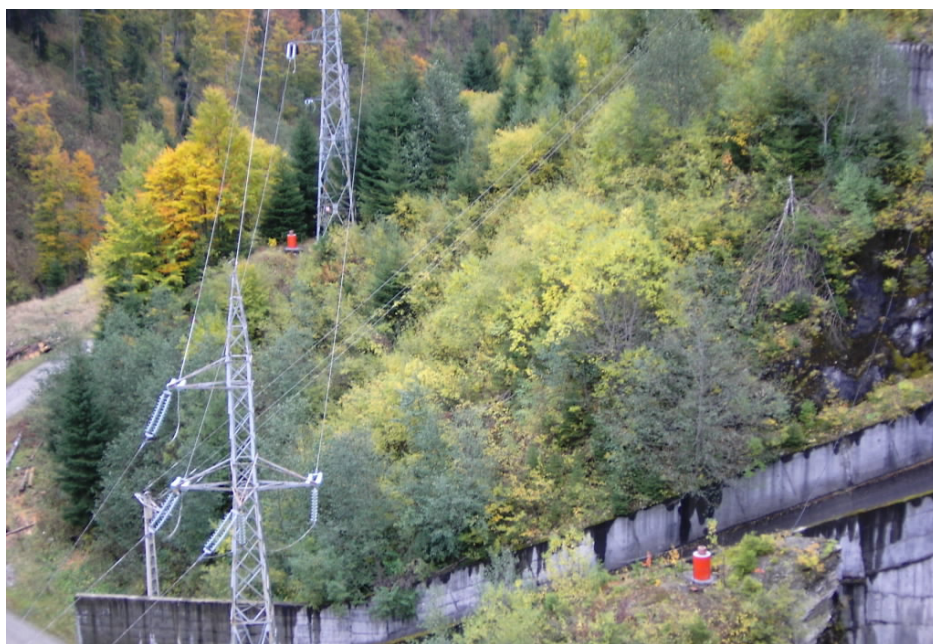
Fig. 5. Barajul Petrimanu- Reperi ficși din rețeaua de microtriangulație
