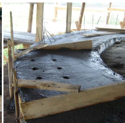
Figura 12. Foraje tiranți la nașteri bolti
