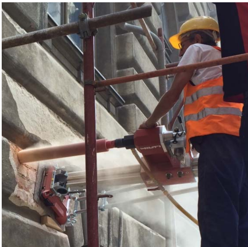
Figura 17. Amplasare tiranți metalici
