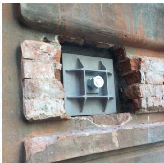
Figura 19. Fixare tiranți în zidărie
