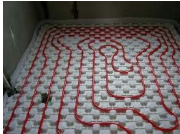
Figura 2. Tehnologia de montare a tubulaturii pe placa profilată
