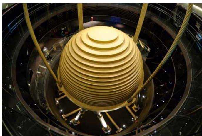
Fig. 5 Pendulul tunului Taipei 101
