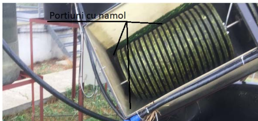
Figura 7 – Porțiuni unde se coagulează namol în unghiuri drepte
