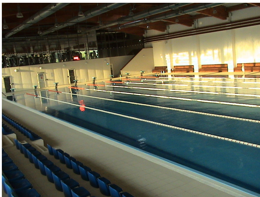
Fig. 11 - Calitatea apei și a construcțiilor de la bazinul de înot T 3
