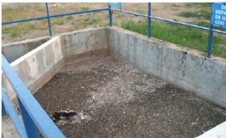
Fig. 1 Chesonul de depozitare a grăsimilor provenite din Separatorul de grăsimi
