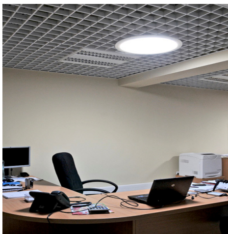
Fig. 4. Iluminarea naturală a birourilor și amplasarea tuburilor de lumină pe terasă
