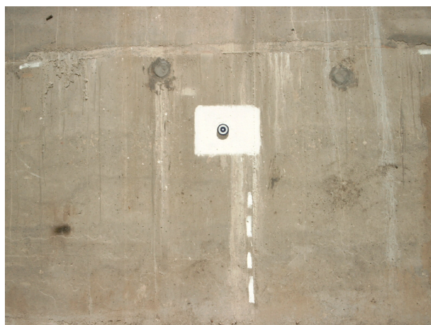
Fig. 4. Reper de microtriangulație pe paramentul barajului Petrimanu
