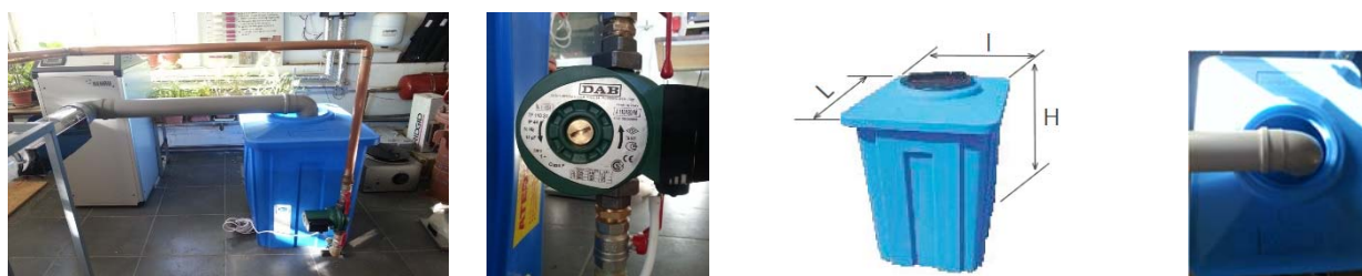
Figura 3– Pompa circulație DAB model A110/180XM; Rezervor tampon deschis 300 l
