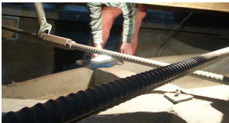
Figura 9. Tensionare manuală tiranți șaibă semi-rigidă
