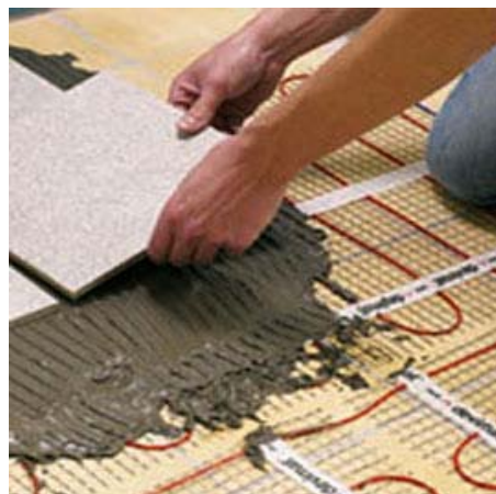
Figura 3. a) Covoraș încălzitor; b) Covoraș de încălzire în șapă.
