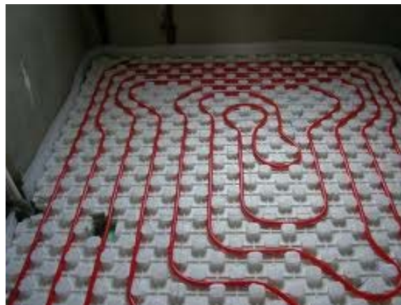
Figura 2. Tehnologia de montare a tubulaturii pe placa profilată
