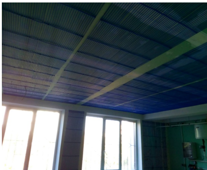
Fig. 1. Poziții de montaj a covoarelor de capilare Clina aplicate pe elementele de anvelopă a încăperii experimentate.
